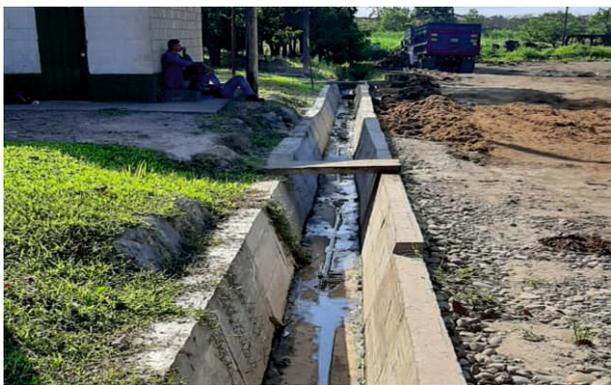
Sistema de canalización de aguas lluvias
